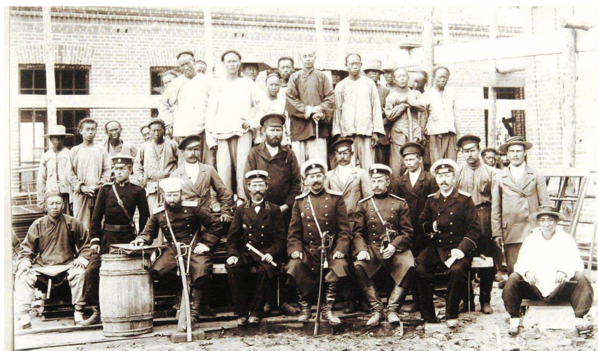
Инженерно-технические работники, мастера и китайские рабочие на строительстве «Арсенала»
